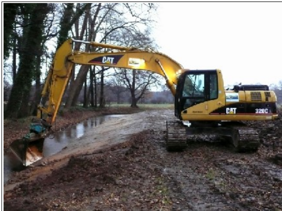
Schweres Gerät im Naturschutzeinsatz – Baggerarbeiten am Trentelgraben. Foto: R. Stankewitz
