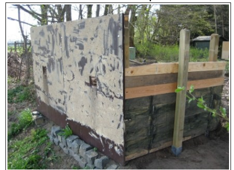
Eisvogelwand im Bau Foto: Gunter Halle
