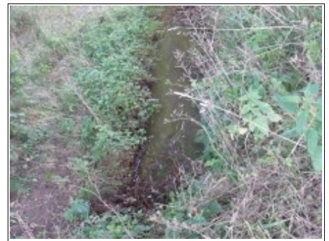
Der untere Trentelgraben soll renaturiert werden. Foto: Ricky Stankewitz
