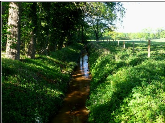
Ein Abschnitt des Trentelgrabens wird renaturiert. Foto: R. Stankewitz
