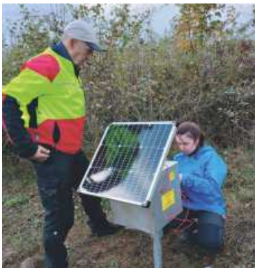
Gunter Halle mit einer HelferIn bei der Verbindung des Weidezaungerätes mit dem Solarmodul.
