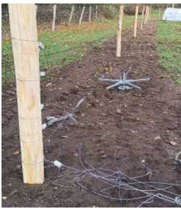
Vorbereitungen zur Installation der stromführenden Drähte.
