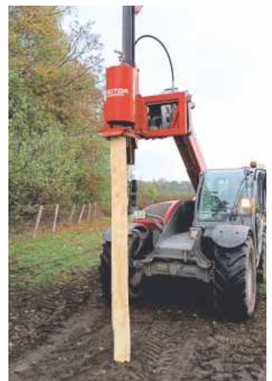
Schweres Gerät war nötig um die massiven Pfosten ins Erdreich zu rammen.
